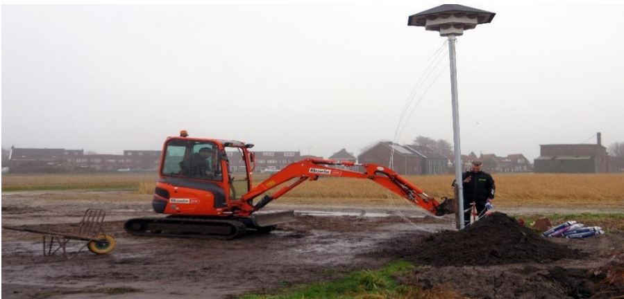
De plaatsing van de huiszwaluwtil in Hillegom (Cees Timmermans)
